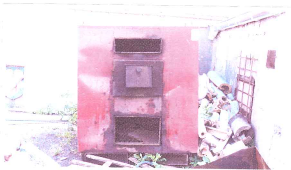
Piec – widok od przodu drzwi paleniska i wyczystki zdemontowane
